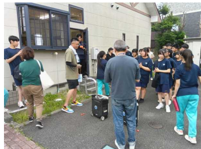
杜乃橋1丁目自家発電起動
